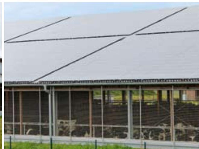
**Licht und Luft** Die beiden identischen Ställe bestehen jeweils aus zwei gegenüberstehenden Pultdachhallen mit unterschiedlich schrägen Dachneigungen. Dachöffnung und Außenwände sind offen und können von unten nach oben mit Netzen verschlossen werden.
