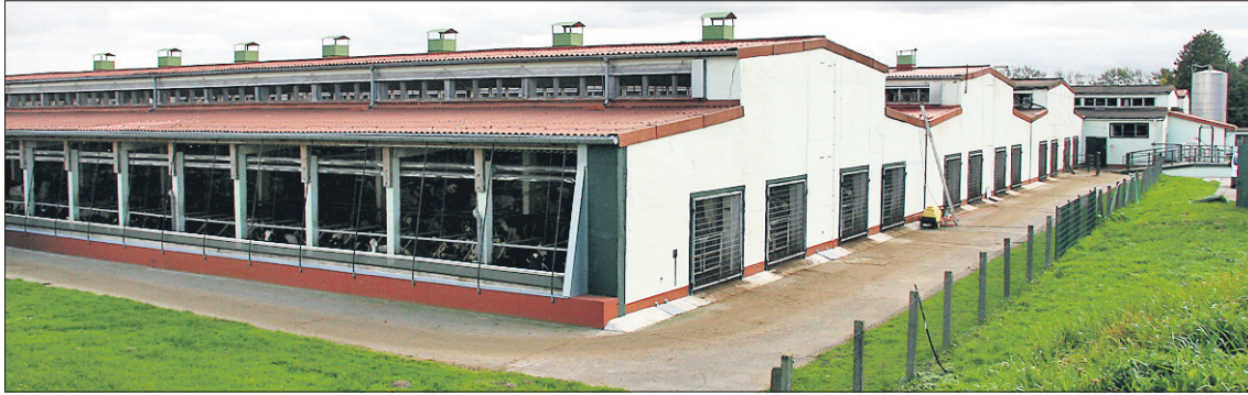
Die Milchviehanlage der Griepentrog KG in Steinhagen (M-V) wurde außen und innen modernisiert.
