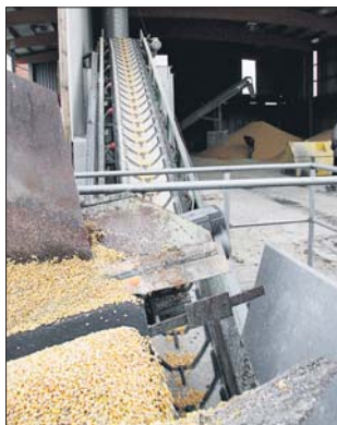
Feuchte Maiskörner trocknet man mit Abwärme der Biogasanlage.
