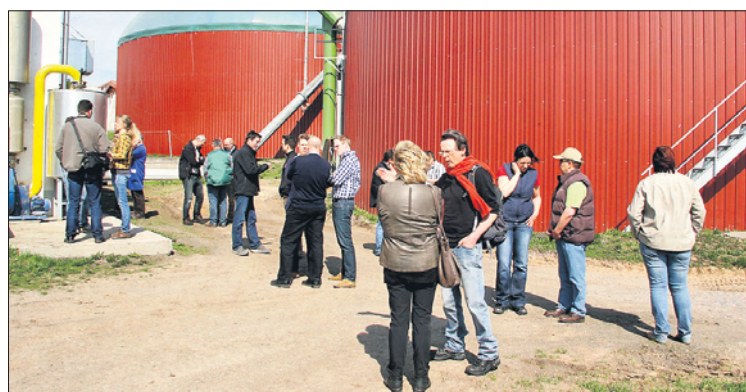
Die IVM-Mitglieder besichtigten in Königsee auch die Biogasanlage, wo vor allem Gülle aus den beiden Milchviehställen verwertet wird.
